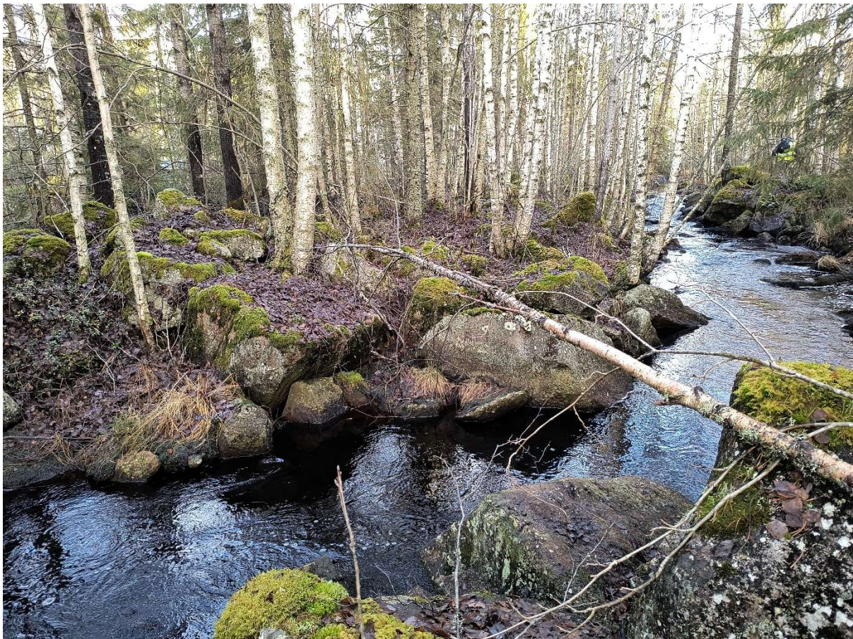
Kuva 10. Perkuukivien palautusta jokeen molemmilta puolilta jokea kohteen 13 yläosalla. Kuvassa näkyvä kaatunut puu laitetaan jokeen. Puu kiinnitetään huolellisesti kivien väliin tai työntämällä rantapenkkaan. Soraikoille rakennetaan paikat perkuukivien palauttamisen yhteydessä.
