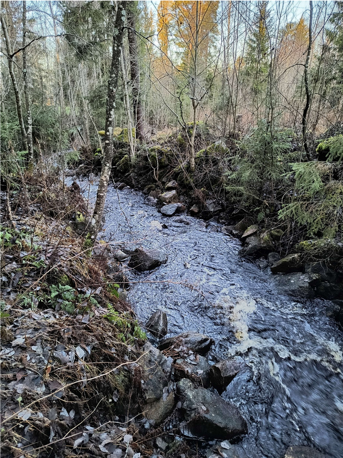
Kuva 5. Perkuukivien palautusta uomaan kohteilla 7 ja 8. Perkuukiviä uoman molemmilla puolilla. Soraikoille rakennetaan paikat perkuukivien palauttamisen yhteydessä.
