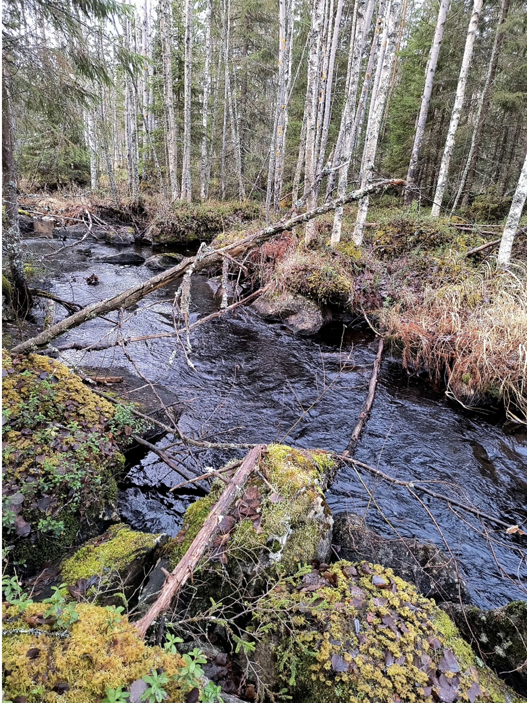
Kuva 20. Kohteella 19 lyhyt perattu osuus, jossa suora virtaama -> kivetään käsityönä uudelleen siirtämällä rautakangella reunoilla olevia kiviä keskemälle jokea
