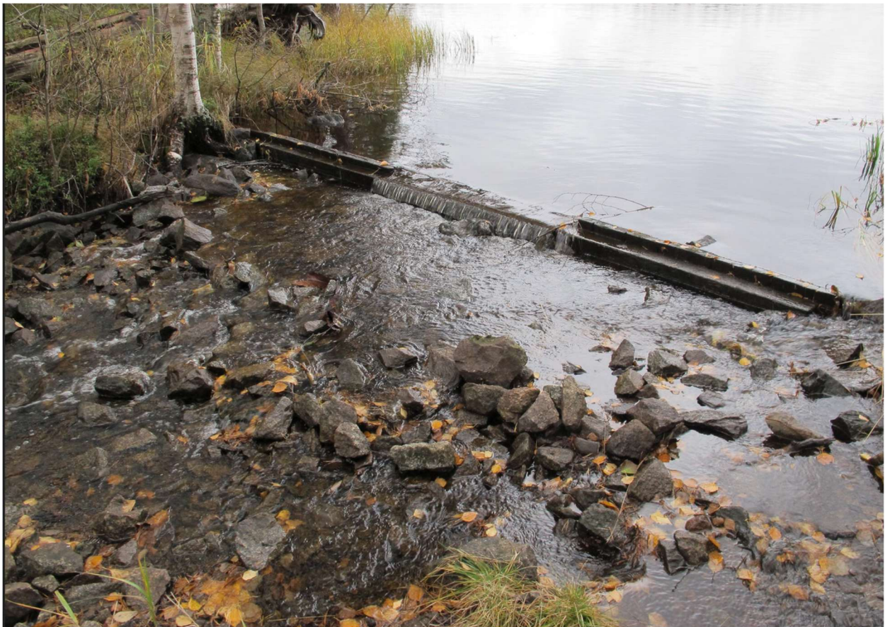
Kuva 31. Pohjapadon alapuoli kivetään konetyönä paremmin, jotta kalojen on helpompi liikkua kohteella
