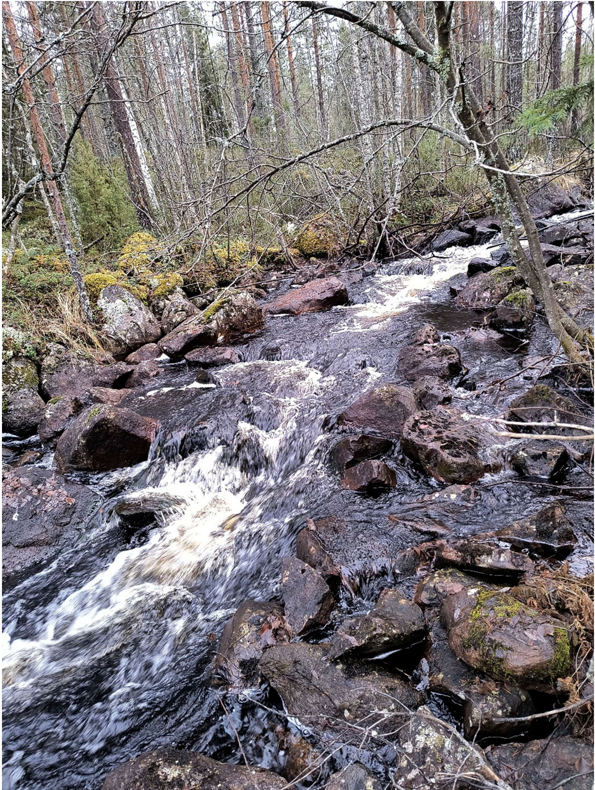
Kuva 25. Kohteella 22 suoraa virtaamaa hajotetaan kiveämällä uudelleen lyhyt pätkä
