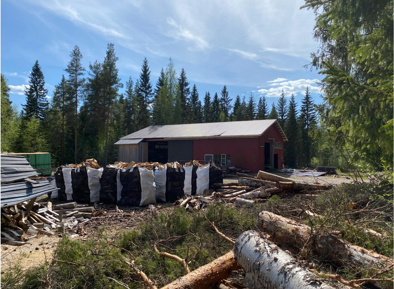
Kuva 10. Suunnittelualueella sijaitsevan sahan rakennus.
