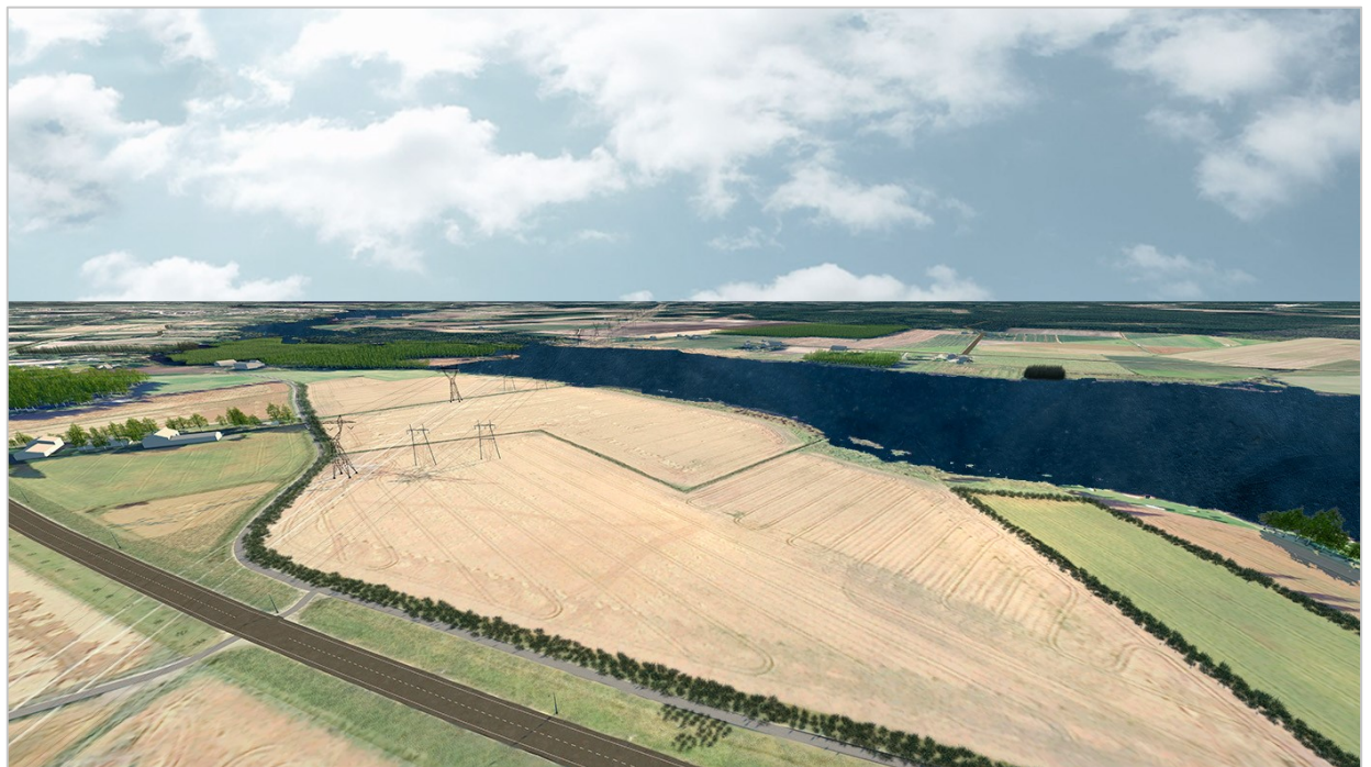
Kuva 107. Reitti 3C havainnekuvana Kalajokilaaksossa Kortejärven eteläosissa olemassa olevien voimajohtolinjojen rinnalla. Reitti kulkee Kalajokilaaksossa ja Kortejärven yli avoimessa maisemassa. Voimajohtojen rivistö korostuu entisestään maisemassa johtokäytävän leventyessä uuden voimajohtolinjan myötä. Voimajohdon sijoittuminen maastoon on esitetty suuntaa antavana ja rakenteiden kuvaus sekä sijoittelu ovat alustavia. (A-Insinöörit Suunnittelu Oy)
