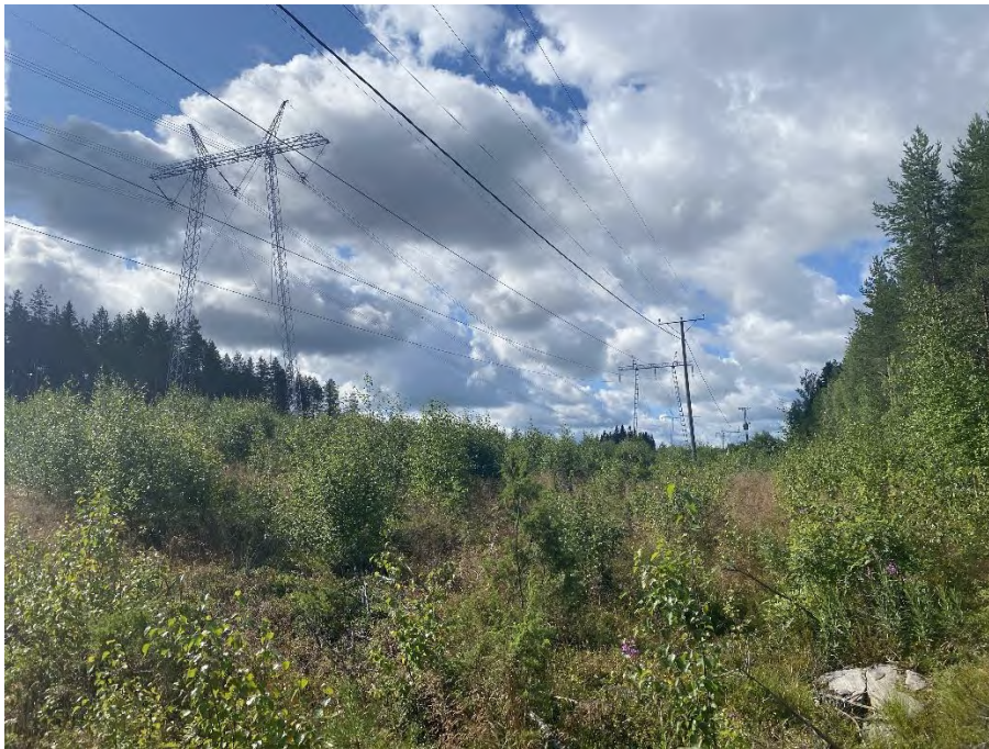
Kuva 2-3. Nykyistä voimajohtojen johtoaukeaa suunnittelualueen itäpäässä.
