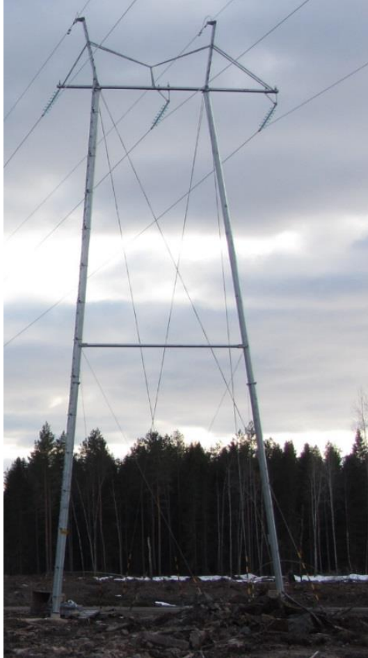
Kuva 3-2. Mallivalokuva harustetusta 110 kV voimajohtopylvästä. Kuva: TLT-Building Oy.
