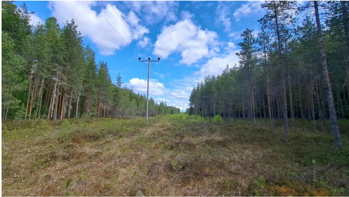
Kuva 3-3. Nykyinen 45 kV johto Hylkirannan itäpuolella. Kuva: TLT-Building Oy.
