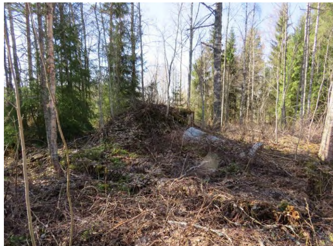
Asuinrakennuksen perustus lounaaseen.
