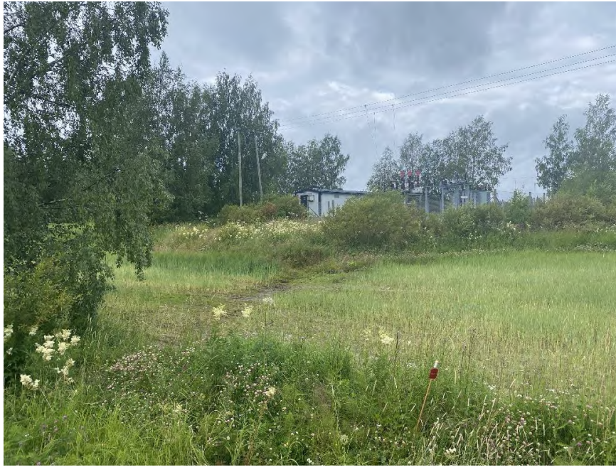
Kuva 2-4. Reisjärven sähköasema ja nykyinen 45 kV johto suunnittelualueen länsipäässä.
